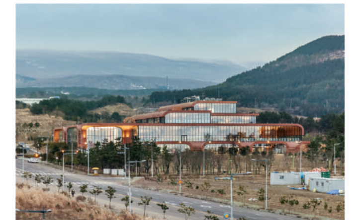
■ 대담한 설계: 제주의 자연 경관과 하나로 어우러진 건축물
